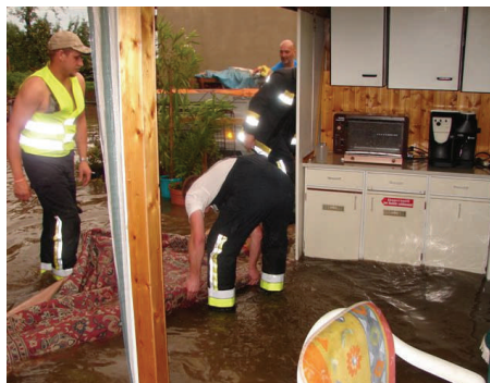
Bild 2: Sicherungs- und Auspumparbeiten nach starken Regenfällen
